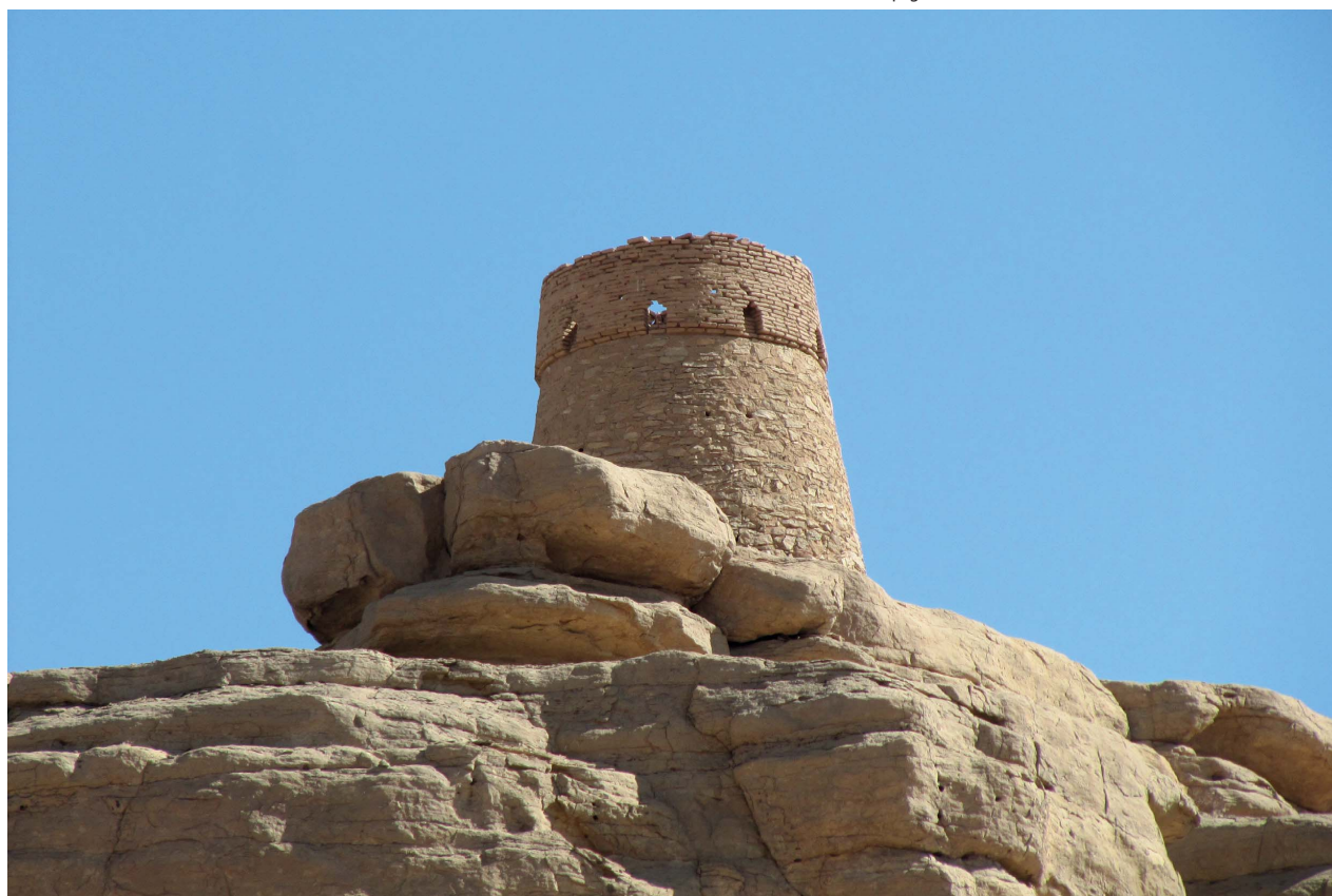
برج کاروانسرای چهل پایه (راه قدیم کرمان، مشهد)
