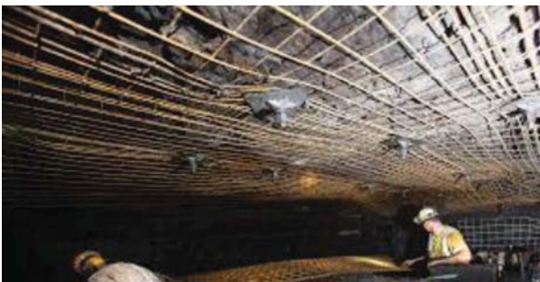
شکل ۴. کاربرد سیستم نگهداری پیچ سنگ
